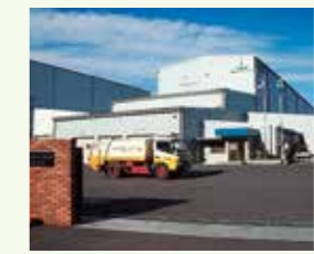
堆肥工場全景
