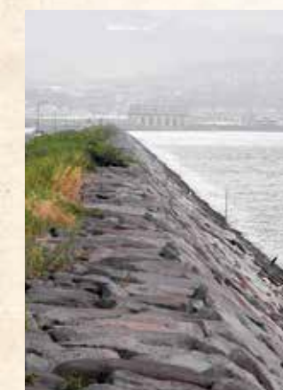
一番奥が諫早湾潮受堤防の水門
