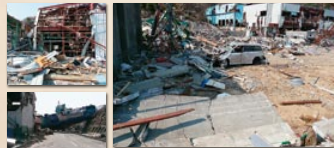
大津波で全壊した加工場と冷凍倉庫
