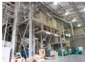
収穫した米を乾燥・貯蔵・選別・出荷するための巨大施設「カントリーエレベーター」
