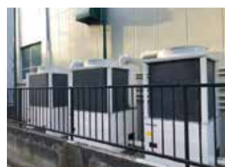
杉並センターに設置した自然冷媒機器
