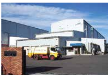
埼玉県の堆肥化工場
