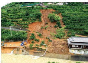
土砂崩れによる崩落現場
