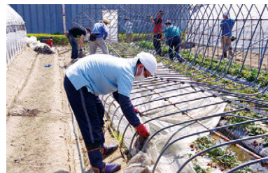
ビニールを剥ぎ、骨組みを解体する職員
