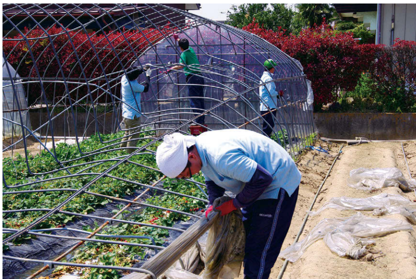
2014年2月の大雪被害で倒壊した(農)埼玉産直センターのビニールハウス撤去作業を手伝う東都生協職員
