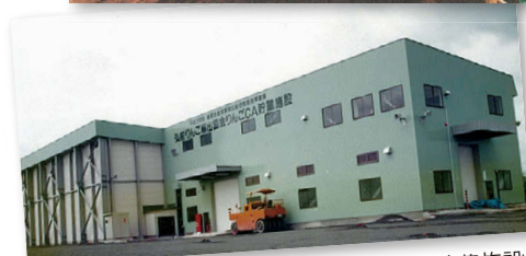
▲土づくり基金を活用したりんごのCA貯蔵施設
