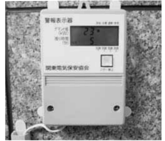
デマンド監視装置 さんぼんすぎセンターの 受付に設置しています。
